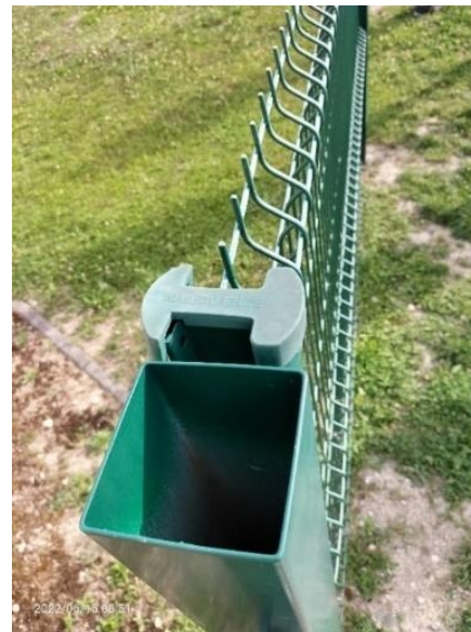
Exemple de piège à faune involontaire : poteau de clôture non obturé dans lequel de petits animaux peuvent tomber sans possibilité de remonter
