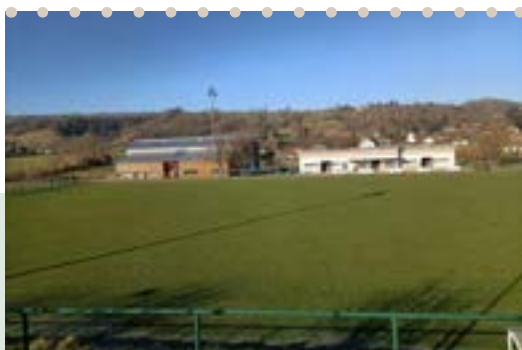
Rénovation du terrain de foot
