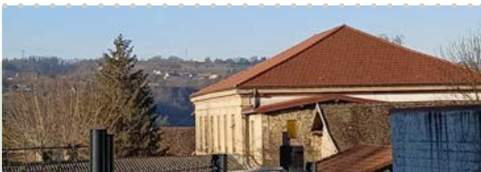
Réfection toiture ancienne mairie
