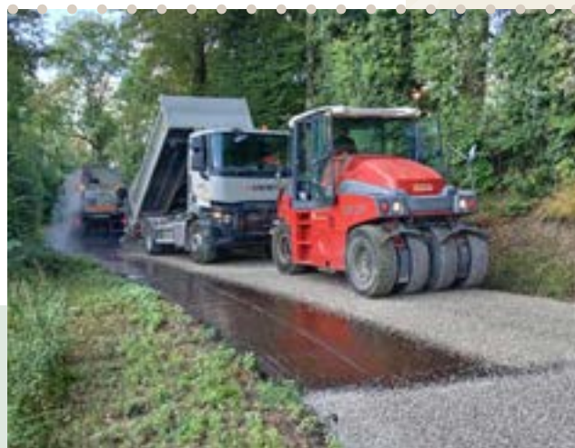
Réfection voirie route de Rabatelière
