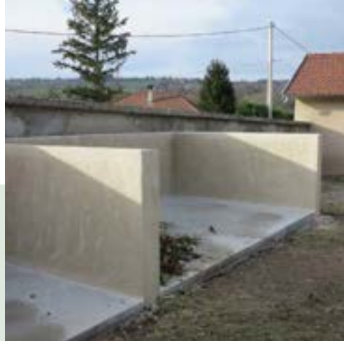
Création espace déchets au cimetière
