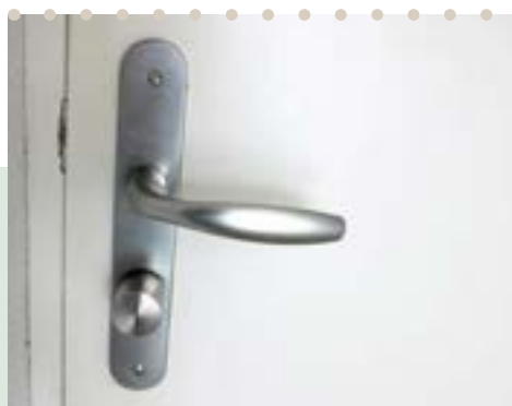
Installation de serrures avec badges sur l'ensemble des portes
