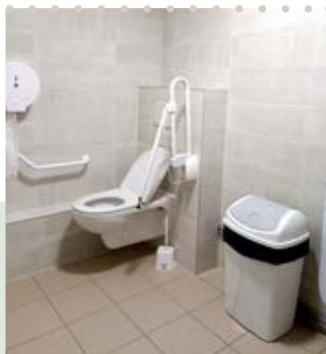
Création toilettes PMR salle polyvalente
