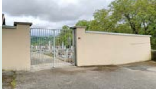
Rénovation mur cimetière de Panissage
