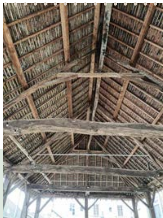
Éclairage de la halle
