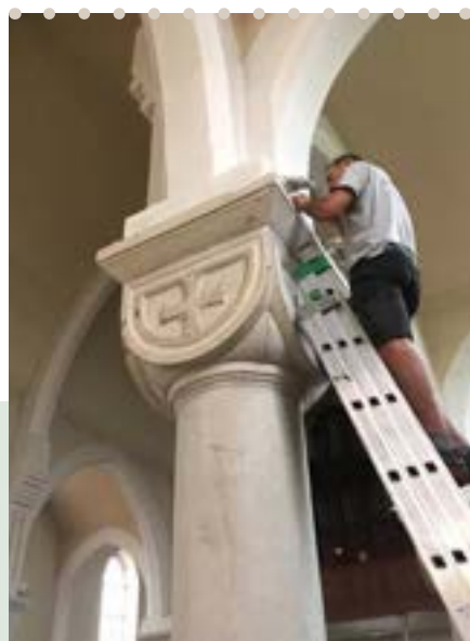
Changement luminaires LED à l'église
