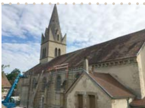
Réfection de la toiture de l'église
