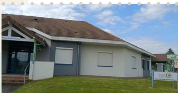
Réfection peinture de la maison de santé
