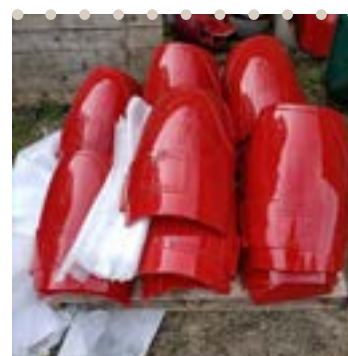
Peinture de tous les coffrets bouches à incendie
