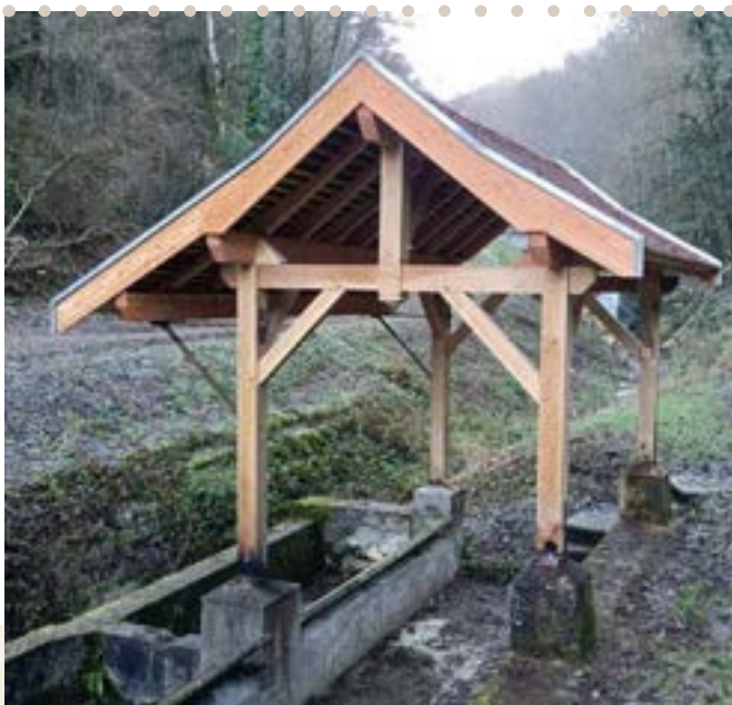
Restauration du lavoir de Vaugelas
