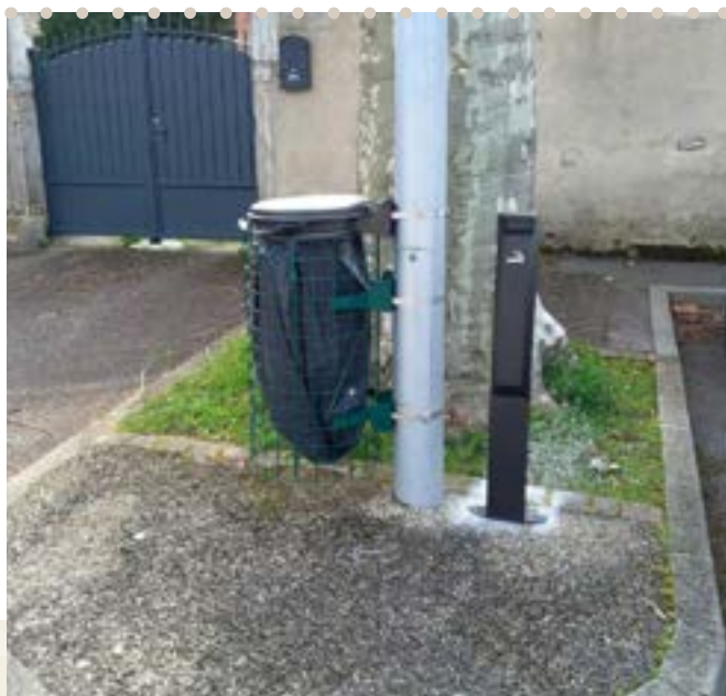
Installation de cendriers
