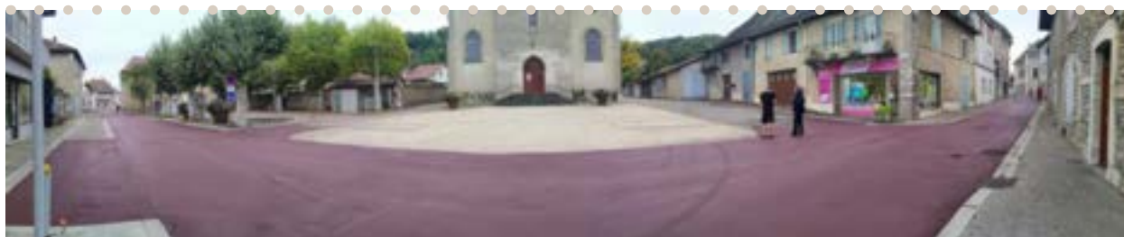
Travaux de voirie espace partagé
