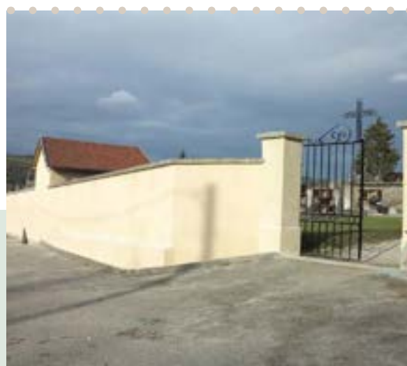
Rénovation mur cimetière de Virieu
