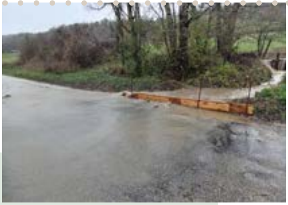
Inondation route de Murinais
