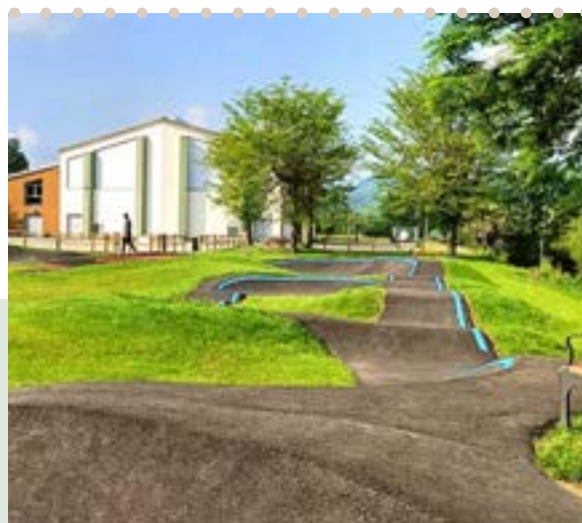
Création du pumptrack
