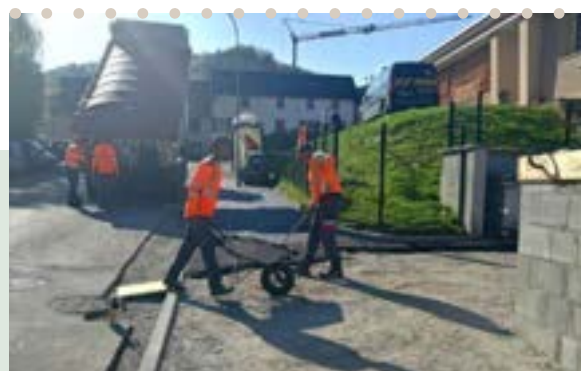
Réfection trottoirs rue de la Bourbre
