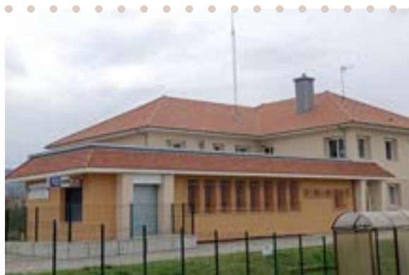
Rénovation énergétique de la gendarmerie
