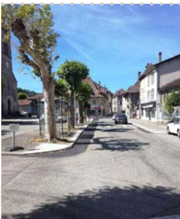
Élargissement rue Camot
