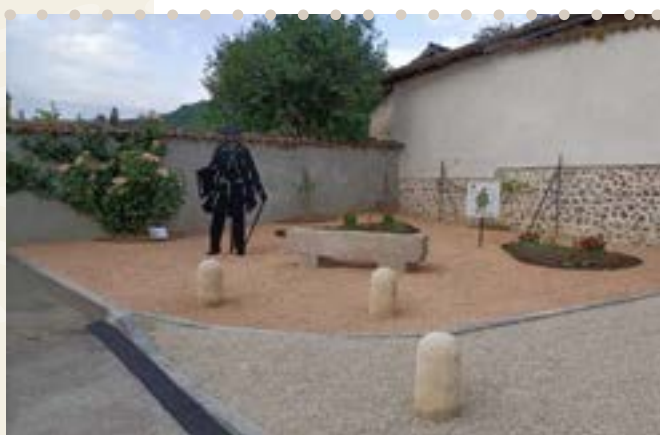
Aménagement square Jongkind
