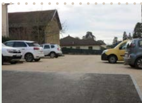
Aménagement du parking rue du château
