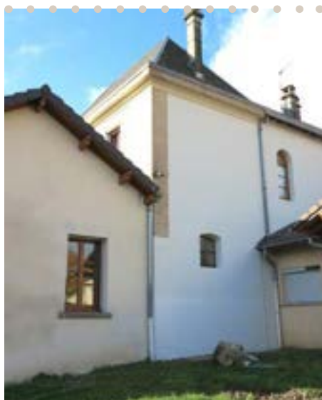
Restauration de la façade de l'ancienne mairie de Panissage
