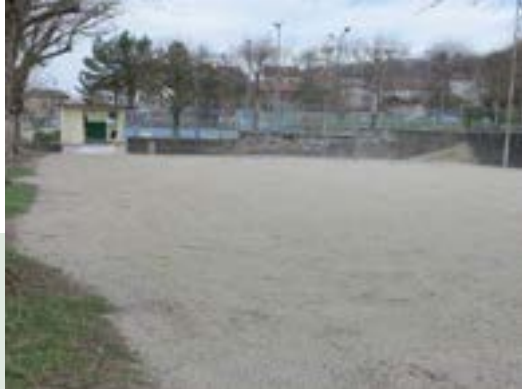
Rénovation des jeux de boules
