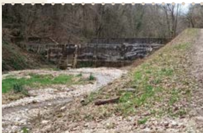
Curage du barrage
