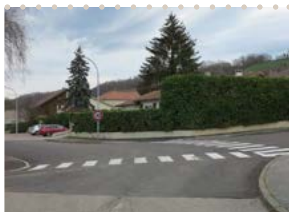
Travaux accessibilité et peinture rue du Grand Champ
