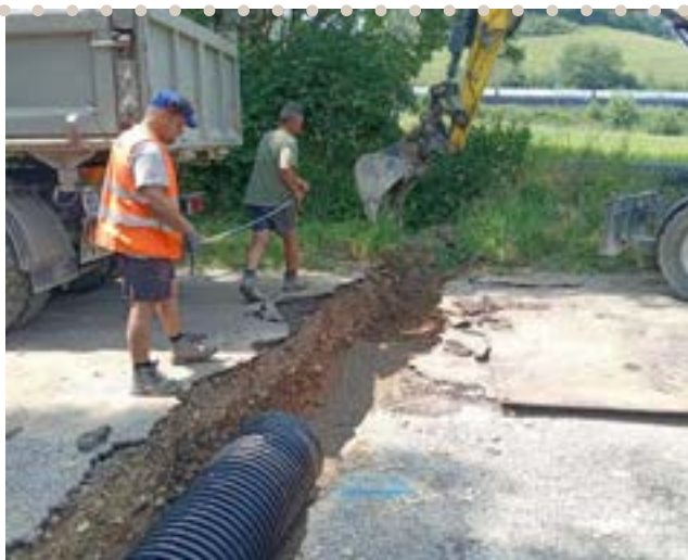
Travaux route de Murinais
