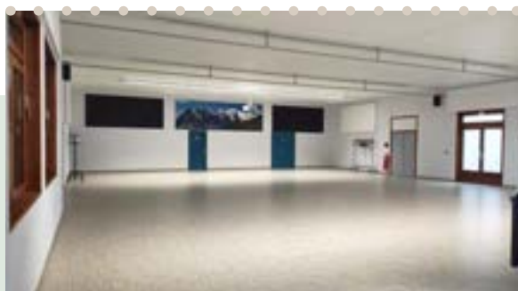
Rénovation de la salle des fêtes de Panissage
