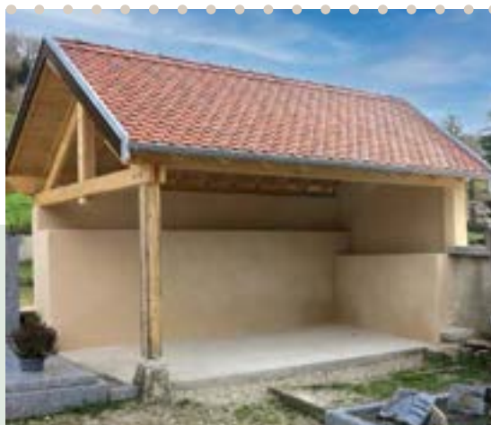
Rénovation de l'abri du cimetière de Virieu
