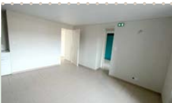
Rénovation appartement 31 rue de Barbenière
