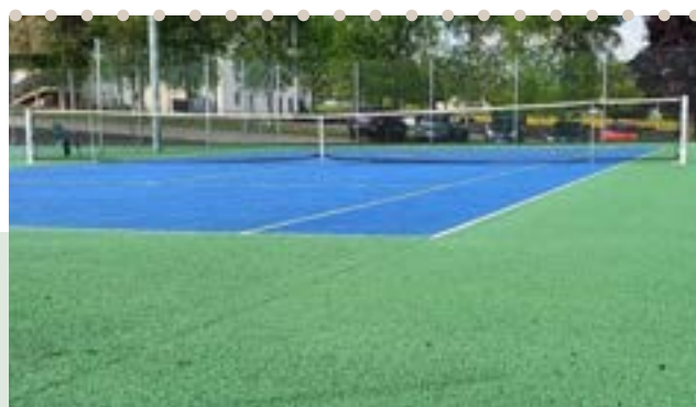
Réfection des terrains de tennis
