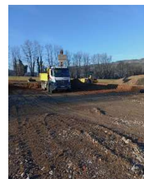
Terrassement de la micro crèche (rue du Grand Champ)
