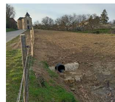
Aménagement du chemin piétonnier RD 51K (route de Chateau Gaillard)
