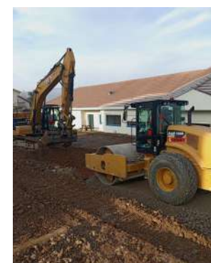
Terrassement de la MSP (rue de la Bourbre)
