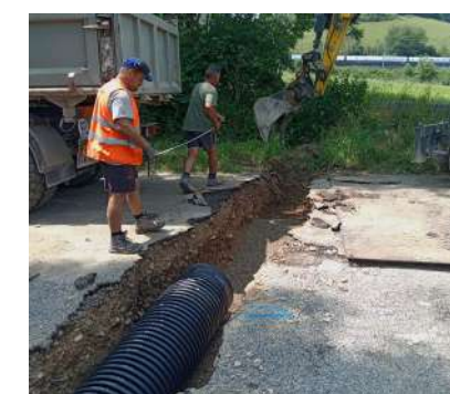
Changement de tuyau (route des Giclas)
