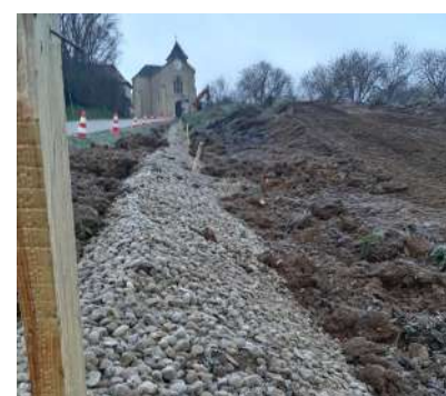
Aménagement du chemin piétonnier RD 51K (route de Chateau Gaillard)
