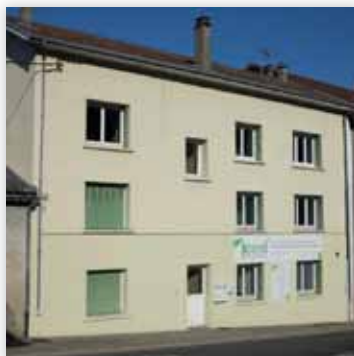
Rénovation appartement 1er étage
