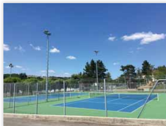
Restructuration des terrains de tennis
