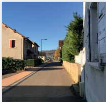
Travaux route de Murinais
