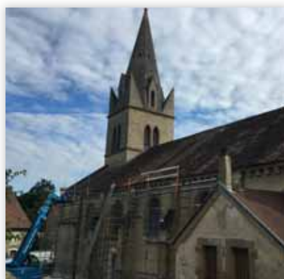
Rénovation toit de l'église
