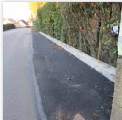
Travaux voirie rue du May
