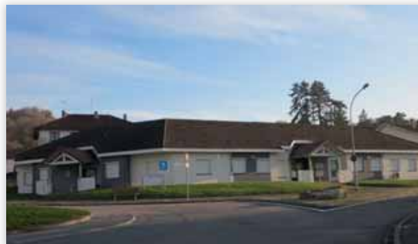
Peinture façade maison médicale
