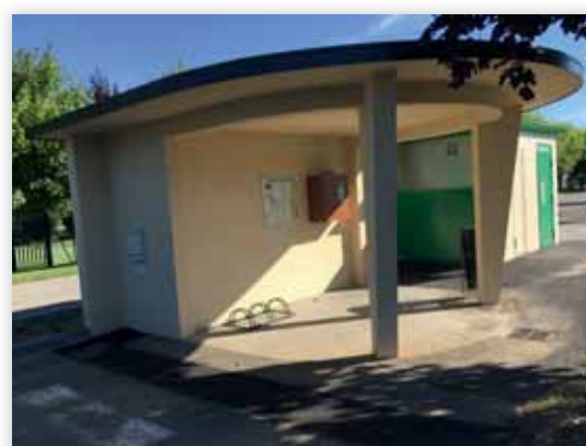
Réfection local électrique
