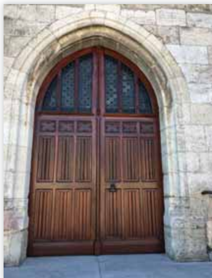
Restauration de la porte de l'église
