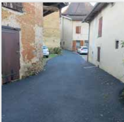
Travaux voirie impasse JB Jongkind
