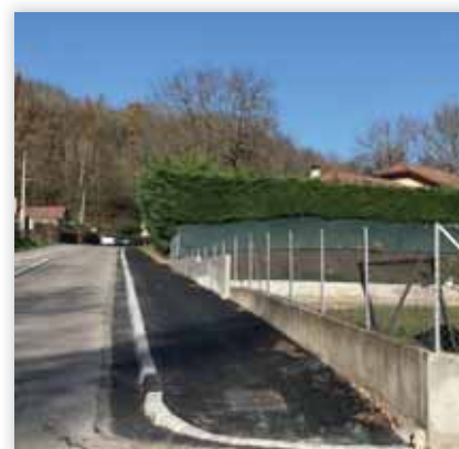
Travaux route de la Tour du Pin
